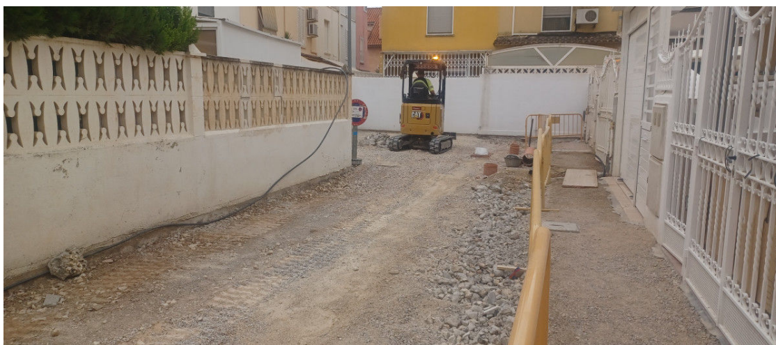
Obras en Alfajar por la red de abastecimiento del agua tras la danaVeolia
